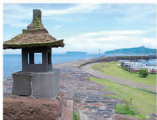
宮ヶ浜港防波堤 捍海隄
